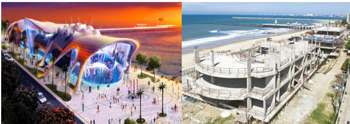
Figura 46 – Fortaleza (CE): Imagem ilustrativa do “Acquário do Ceará” e situação em obras.
