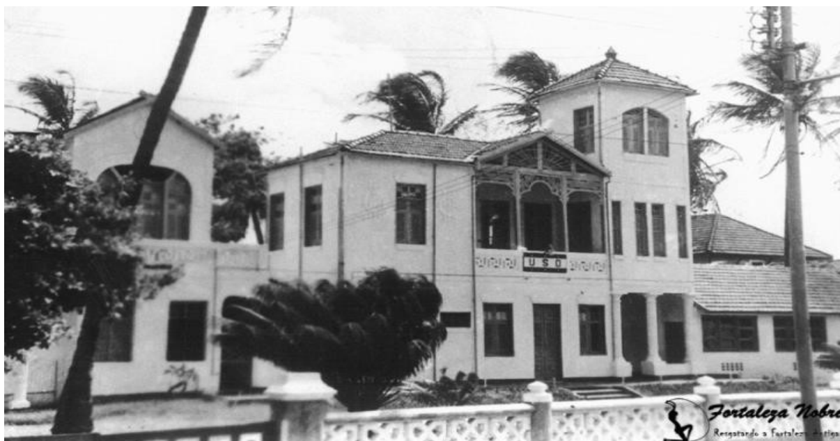
Figura 8 – Fortaleza (CE): A casa Vila Morena com a placa da U.S.O em 1940.
