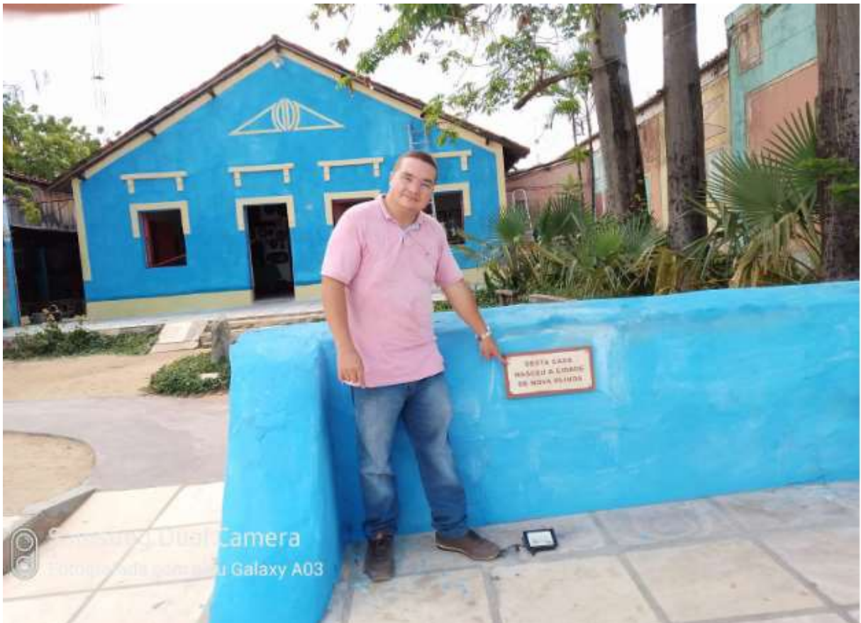
Figura 6- Fachada principal da Casa Grande- Nova Olinda- CE
