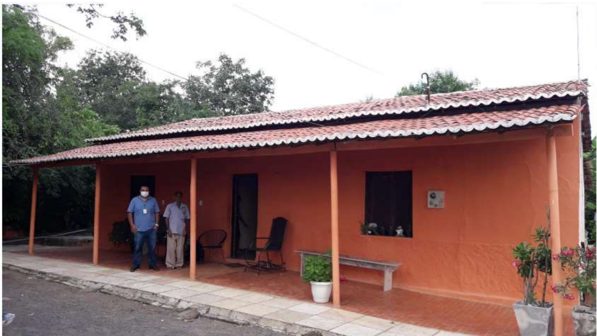
Figura 9- Fachada principal da residência do Sr. José Artur na localidade de Lagoa dos Patos, Nova Olinda- CE
