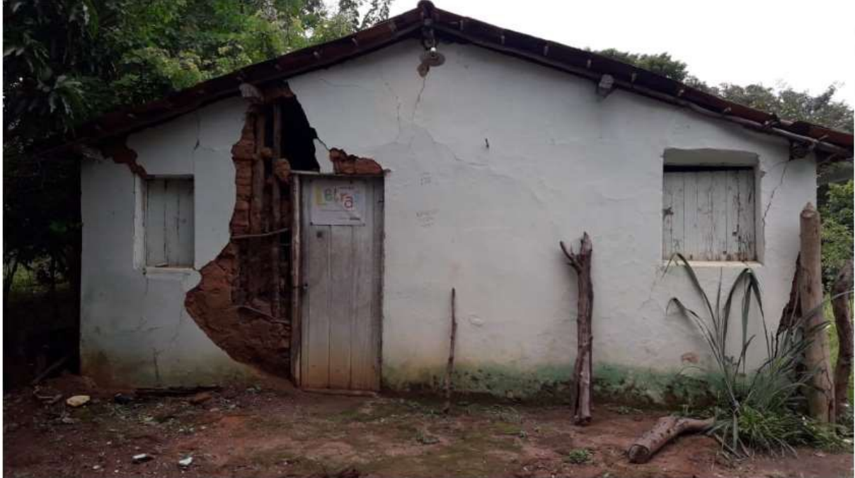
Figura 29- Antiga casa/depósito onde eram armazenados e beneficiados os produtos na Baixa do Maracujá em Crato- Ceará
