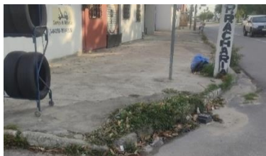
Figuras 125, 126 e 127 – Quarteirão formado por comércios. Não existe rebaixamento da calçada nas esquinas
