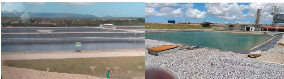
Figura 5; Lagoa de efluentes sem e com tratamento.
