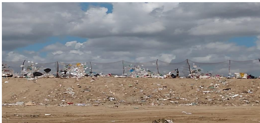
Figura 3: Tela de proteção de resíduos sólidos no aterro sanitário ASMOC. Foto: Autoria própria, 2020.
