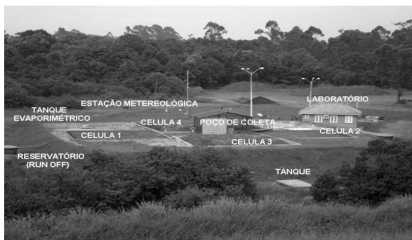
Figura 1 - Vista geral da unidade protótipo piloto.
