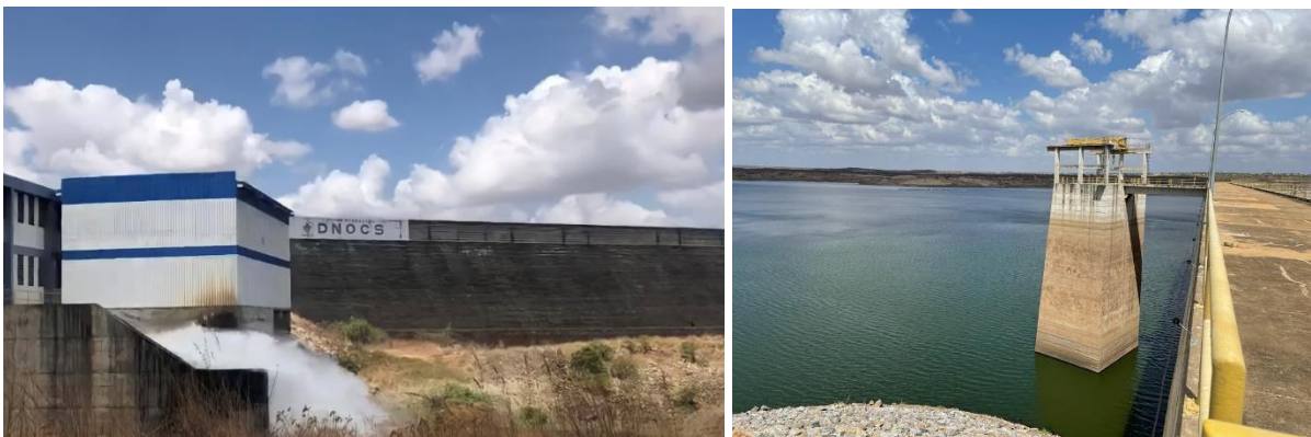
Figura 2 – (a) Liberação de água do reservatório com vista para o paramento de jusante; (b) Torre de tomada d'água
