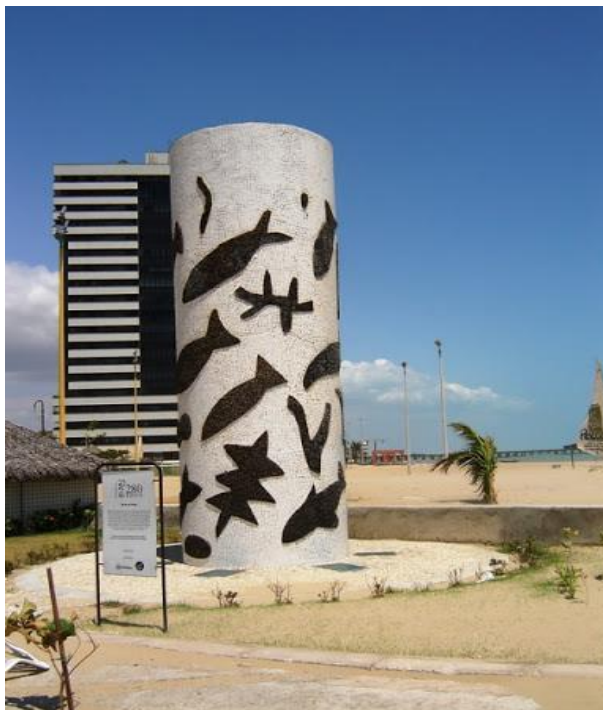
Figura 43 – Caixa d'água dos peixinhos
