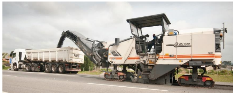
Figura 02 – Fresadora de pavimento asfáltico.
