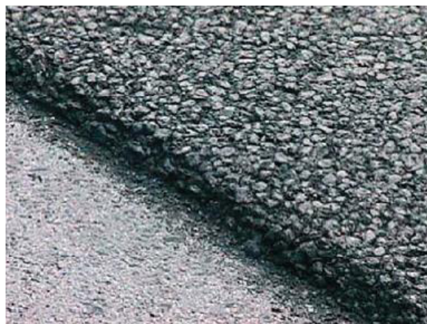
Figura 24 – Detalhe da superfície de um pavimento com SMA.
