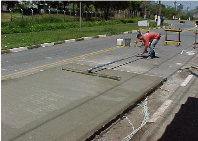
Figura 21 – Aplicação de Whitetopping.
