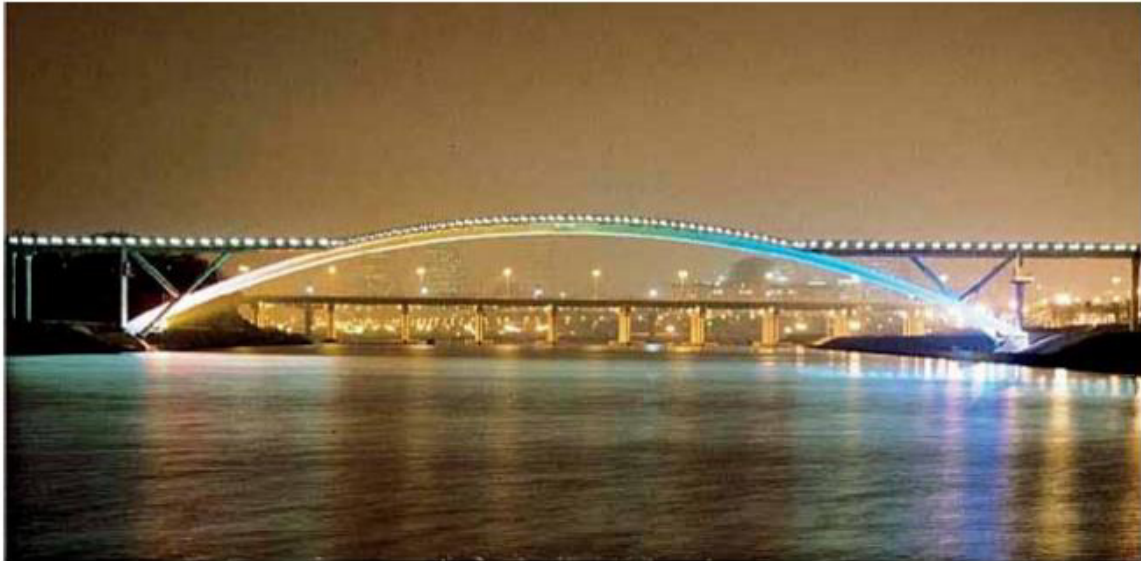
Figura 5 - Passarela Seonyu, Coréia do Sul com um vão livre de 120m feito com CUAD
