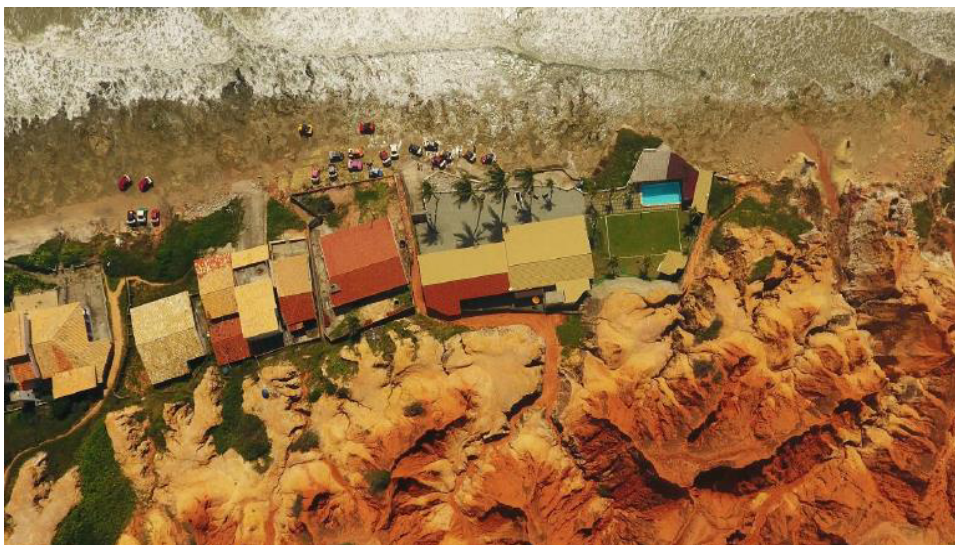
Figura 34 - Construções na região do Monumento Natural das Falésias de Beberibe.
