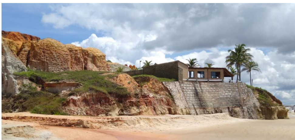
Figura 42 - Casa construída no topo da falésia na Praia de Morro Branco.
