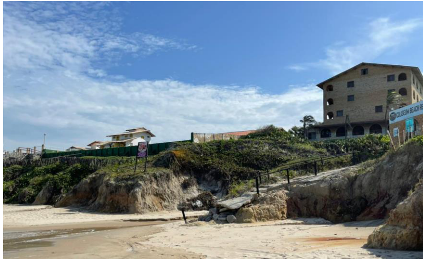
Figura 35 - Hotel e residências construídos no topo das falésias na Praia das Fontes.
