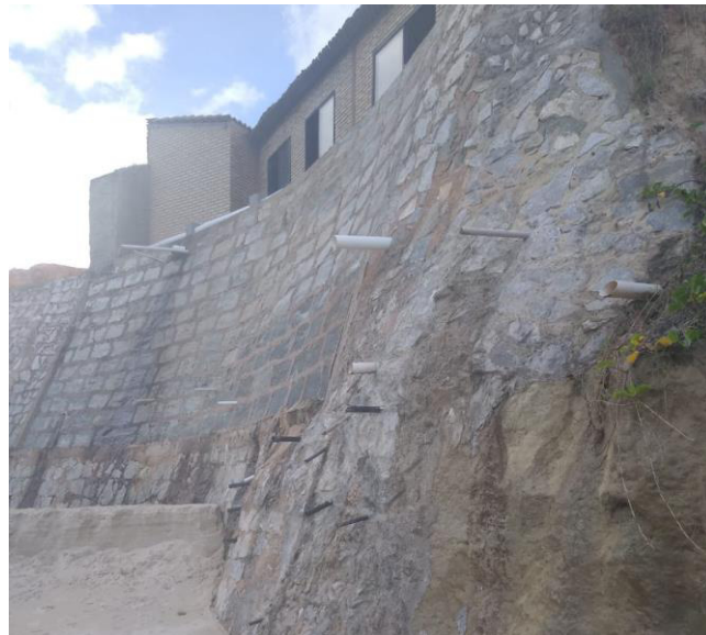
Figura 43 - Drenagem residencial de uma casa localizada na Praia do Morro Branco.
