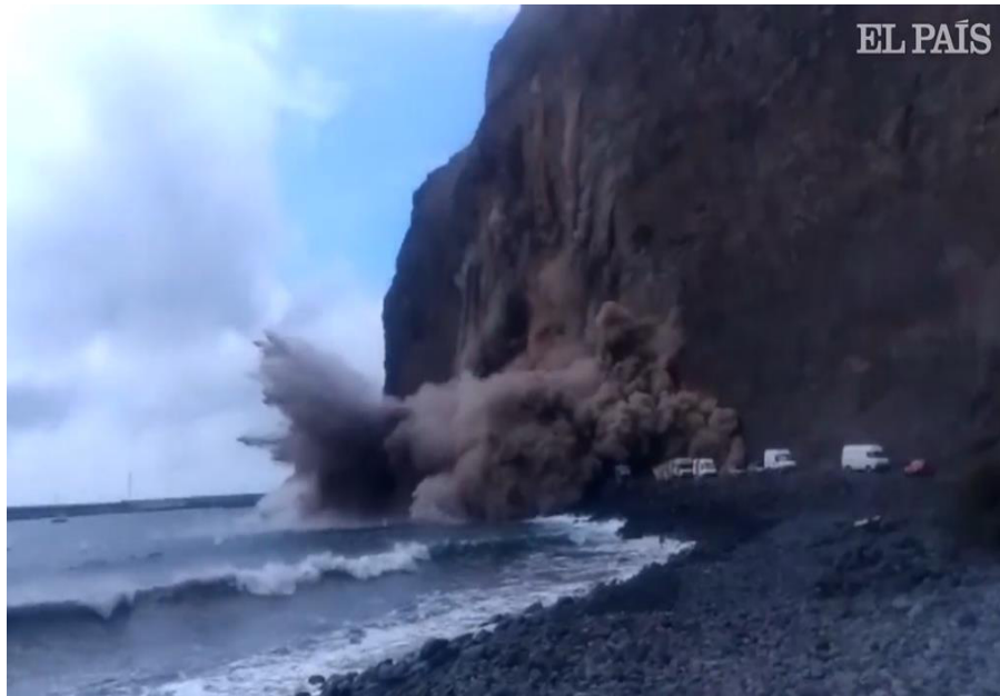
Figura 6 - Deslizamento na encosta da Praia de Argaga, na Espanha.
