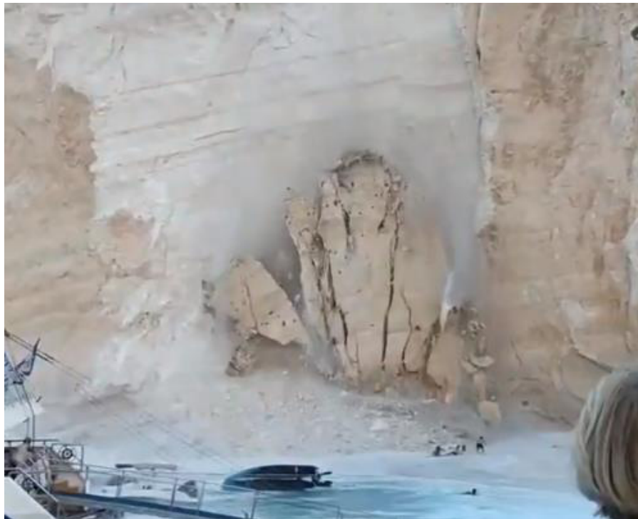
Figura 7 - Momento do desabamento de parte da falésia na Ilha de Zante.
