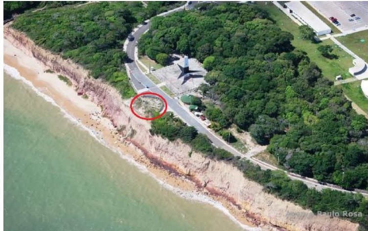
Figura 11 - Área interditada após desabamento de falésia.
