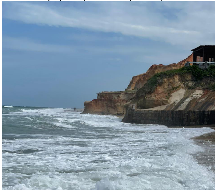
Figura 38 - Construção no topo da falésia na Praia de Morro Branco com um muro de contenção para impedir a erosão pelo avanço do mar.
