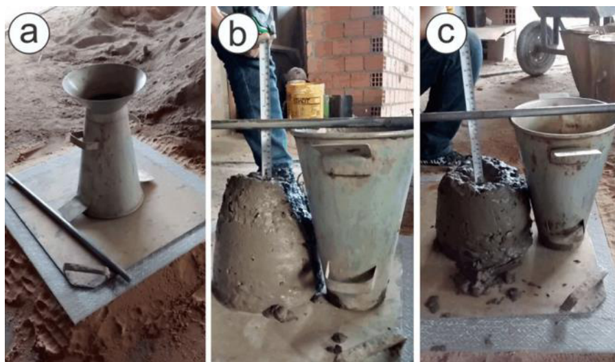
Figura 8 - Ensaio de abatimento de tronco de cone
