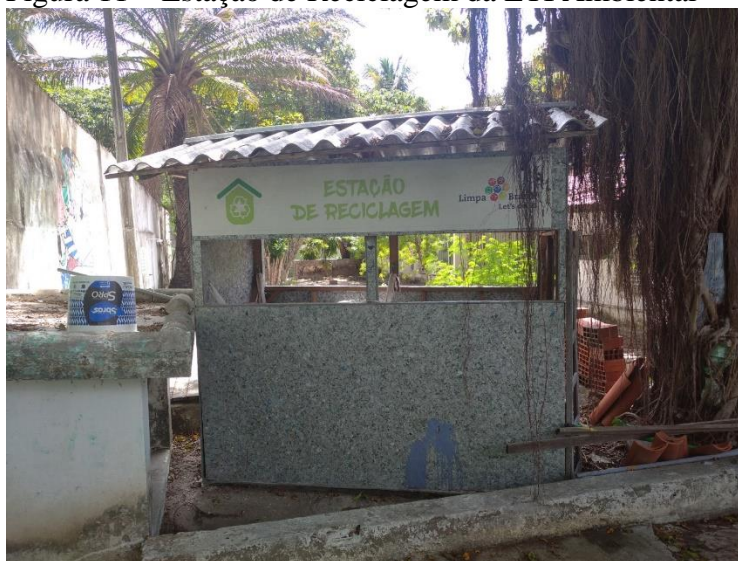
Figura 11 – Estação de Reciclagem da ETI Ambiental
