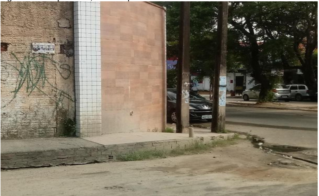
Figura 22 - Calçada alta, sem rampa e estreita.
