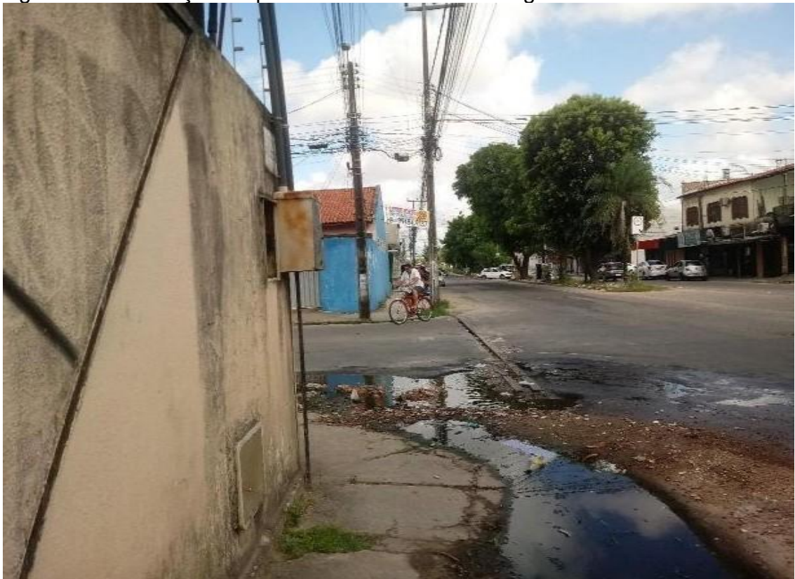
Figura 20 - Obstrução do passeio com caixa de energia elétrica
