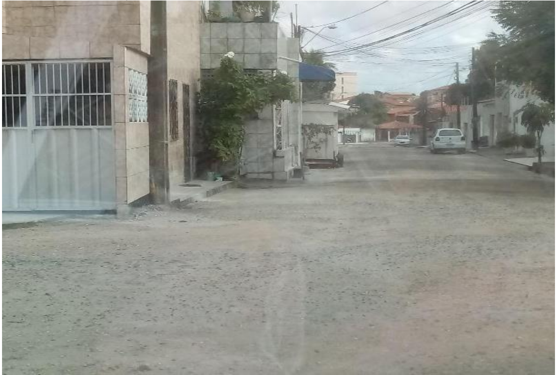
Figura 15 - Avanço de Edificação.
