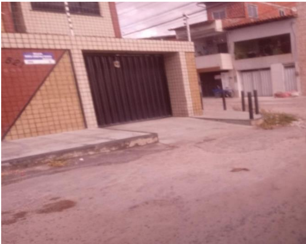
Figura 14 - Trilhos na calçada, ausência de rampa.
