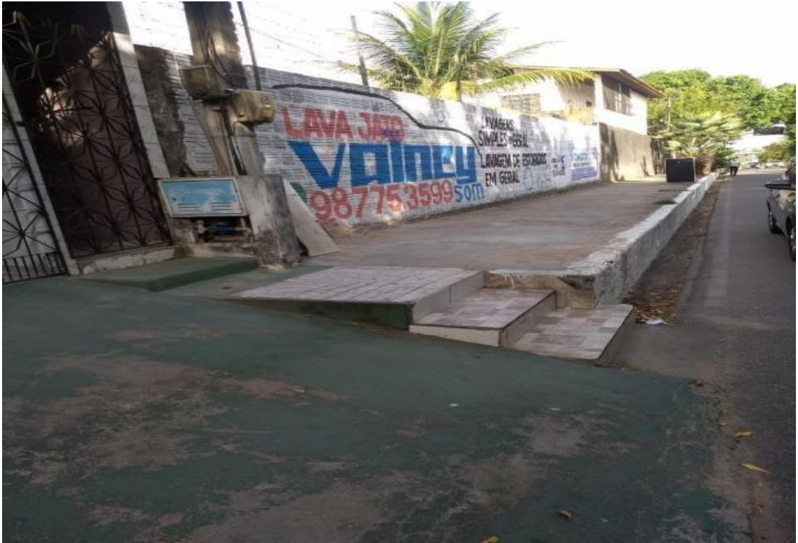
Figura 23 - Calçada alta com degraus e inclinada.
