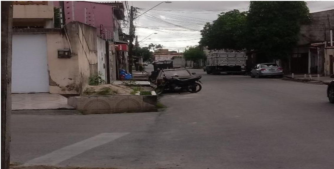
Figura 18 - Canteiro e areia obstruindo a calçada e falta de rampa
