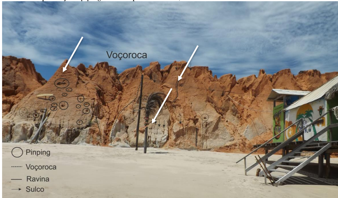
Figura 6- Sulcos, ravinas e voçorocas em falésias arenosas semiconsolidadas, no qual as voçorocas estão sinalizadas com uma linha pontilhada, as ravinas com linhas e os sulcos com setas pretas. Além disso, é sinalizado a presença de pipings na escarpa das falésias, sinalizados com círculos.
