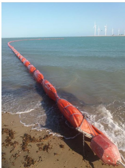
Figura 25 – Barreira de Contenção instalada na foz do Rio Jaguaribe/Fortim colocada segundo indicação das cartas SAO (Sensibilidade ambiental ao óleo).
