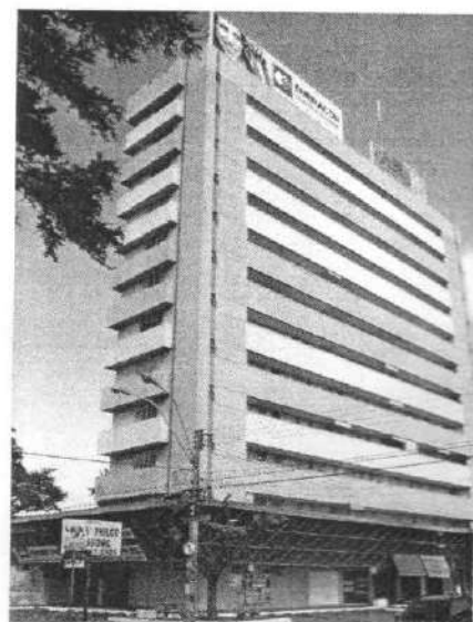
Fig. 46. Edifício comercial ocupa, atualmente, o lote da antiga residência Otávio C. de Alencar.
