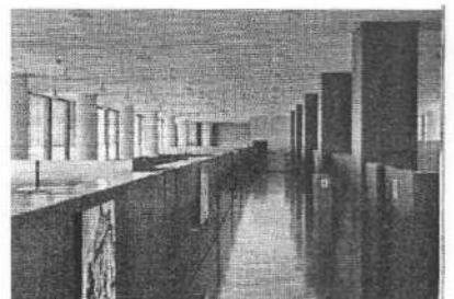
Fig. 28. Vista geral de um pavimento tipo.
