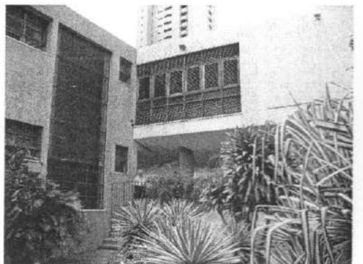
Fig. 90. Fachada oeste (parcial).
