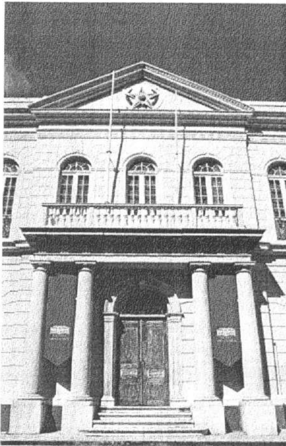
Fig. 07. ADOLPHO HERBSTER. Assembléia Provincial. Construção: 1856-1871. Detalhe do pórtico em pedra de lioz.
