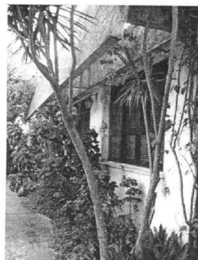
Fig. 39. NEUDSON BRAGA. Residência Kleber Lima Chaves, 1971. Empena fachada leste.
