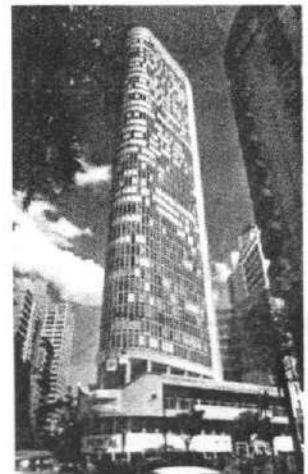
Fig. 82. A. FRANZ HEEP. Edifício Itália. São Paulo, 1956.
