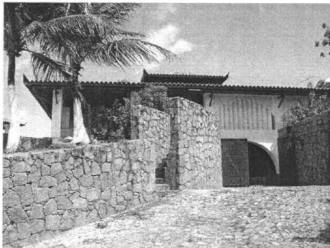
Fig. 138. Fachada norte / acesso.
