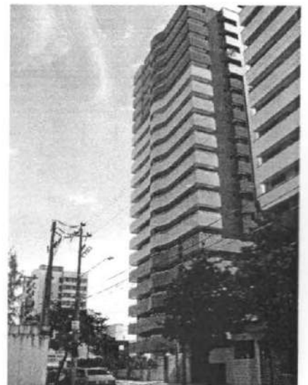
Fig. 52. Edifício residencial multifamiliar localizado no antigo lote da residência José Otoch.
