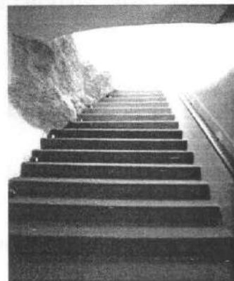
Fig. 68. Residência de Canoas. Vista escada
