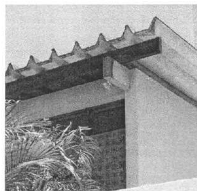
Fig.57. Detalhe ventilação do forro.
