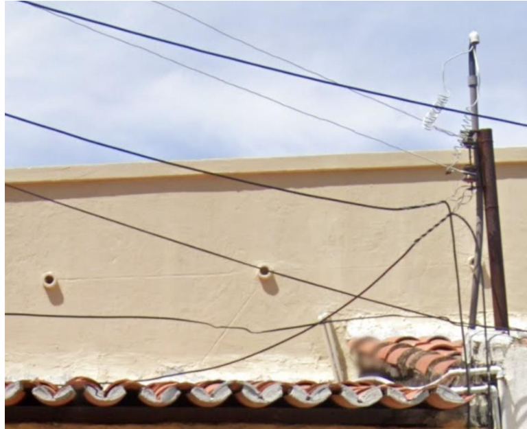
Figura 11 – Padrão de entrada monofásico
