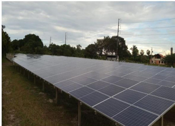
Figura 5 – Usina sob análise após instalação.
