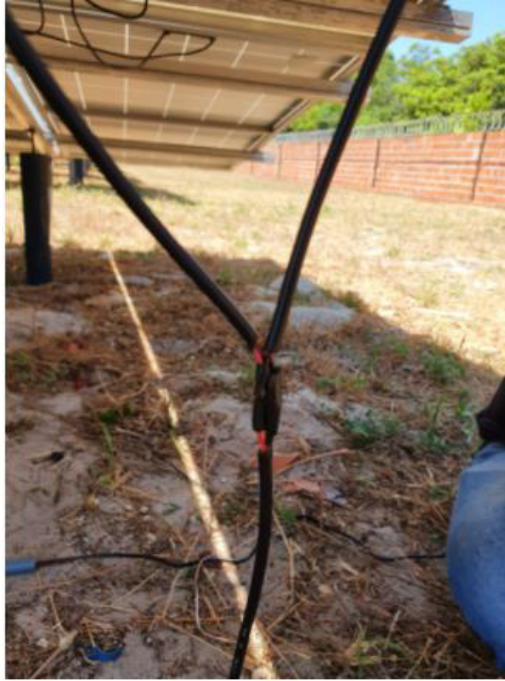
Figura 35 – Soldagem do Sensor de temperatura e cabo manga 3 vias
