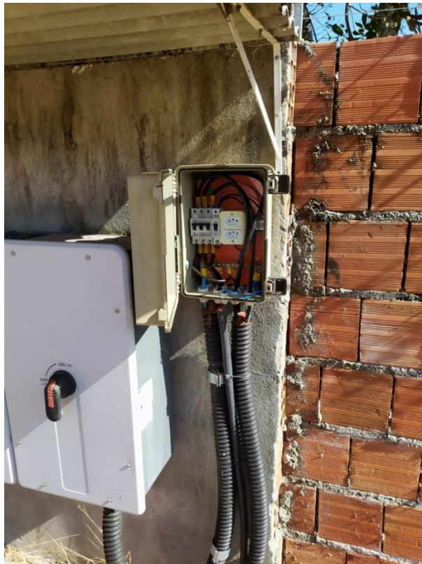
Figura 27 – Ponto de Conexão 220V e Local de Fixação do módulo de Alimentação
