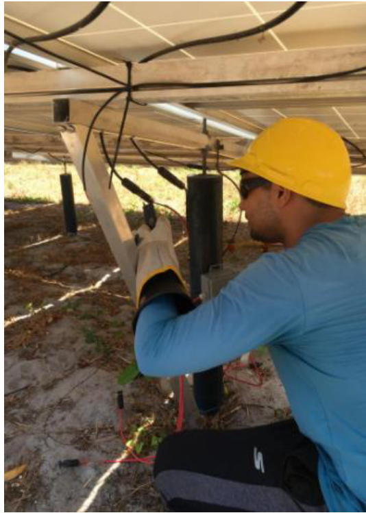
Figura 33 – Abertura do Circuito das Strings
