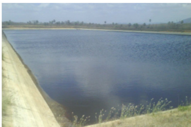
Figura 05 - Lagoa de Estabilização
