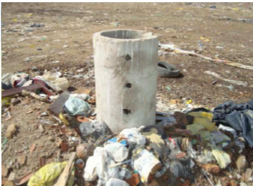
Figura 06 - Dreno de queima do biogás
