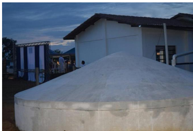
Figura 3.6: Entrega de cisternas escolares na zona rural.
