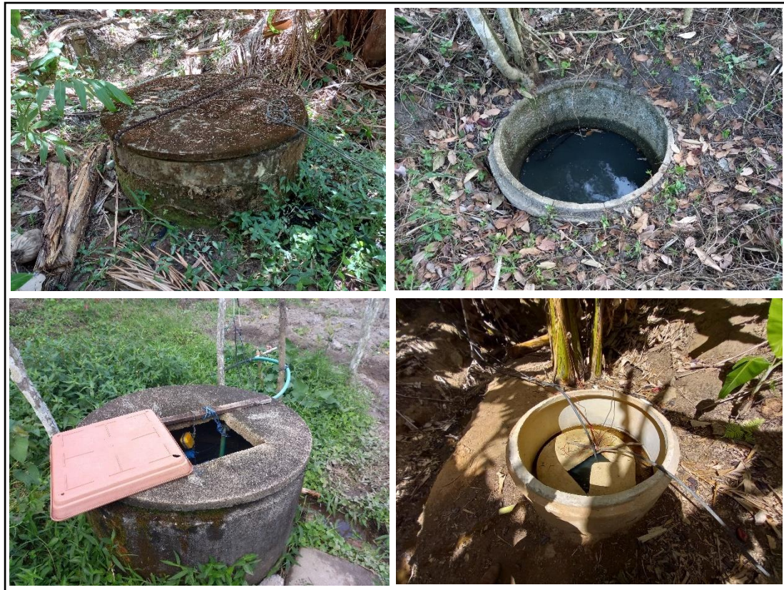
Quadro 8 - Nascentes com intervenções estruturais
