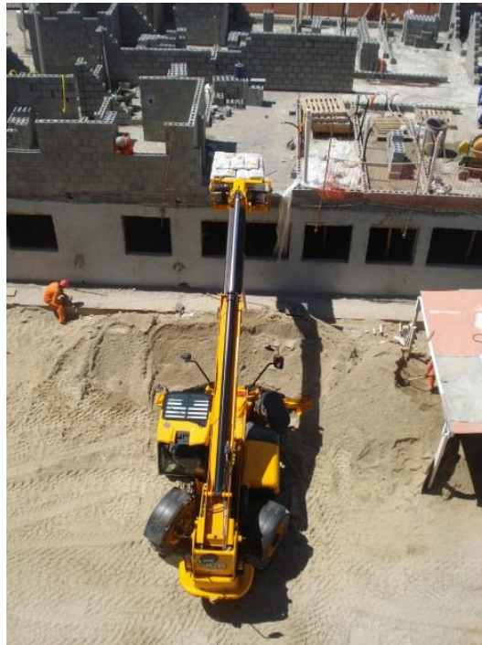
Figura 26: Transporte horizontal com Manipulador skytrack.
