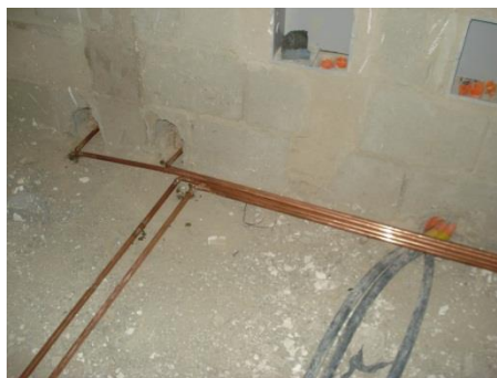
Figura 46 – Instalação de gás após a execução da alvenaria com quebra de blocos.
