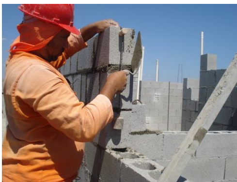
Figura 29: Pedreiro utilizando colher para execução da alvenaria estrutural.
