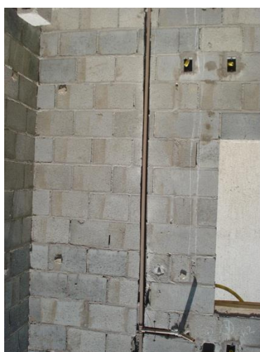
Figura 15: Projeto Instalação não compatibilizado.
