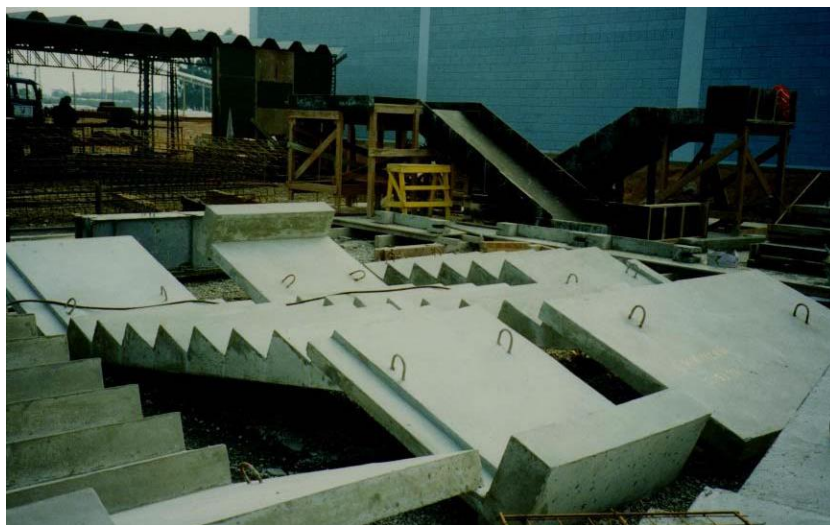
Figura 19 - Escada tipo Jacaré.
