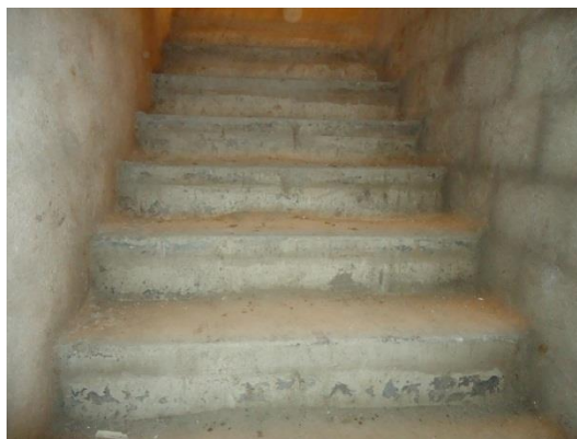
Figura 59: Escada executada com degraus pré-moldados.
