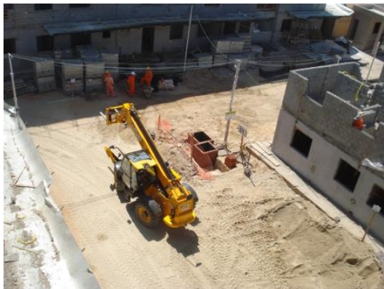
Figura 27: Transporte vertical com manipulador skytrack.
