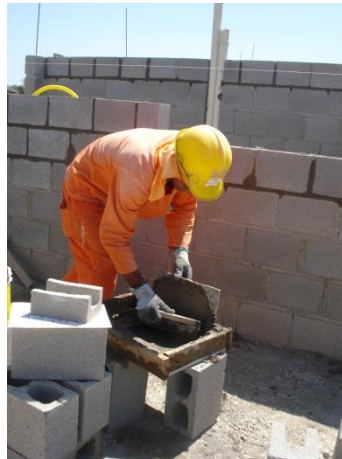
Figura 37: Utilização de espátula para assentamento de alvenaria.
