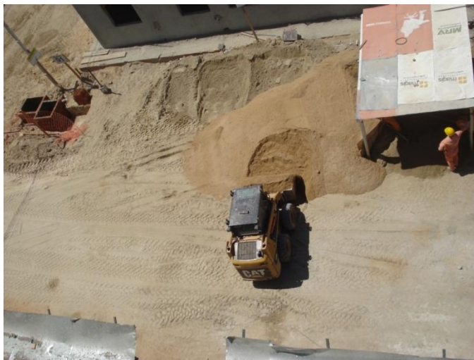
Figura 42: Retroescavadeira em funcionamento.
