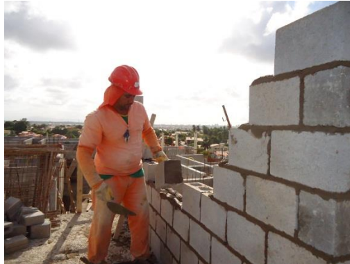
Figura 57: Execução de Alvenaria Estrutural com utilização de colher de pedreiro.
