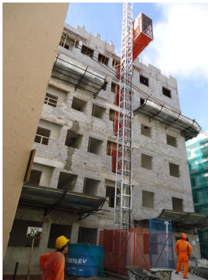
Figura 24: Empreendimento utilizando elevador Cremalheira.
