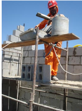
Figura 30: Pedreiro utilizando palheta para execução da alvenaria estrutural.
