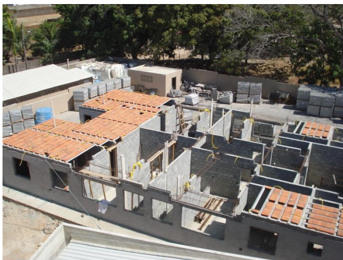
Figura 22: Execução de Laje Trelaçada.
