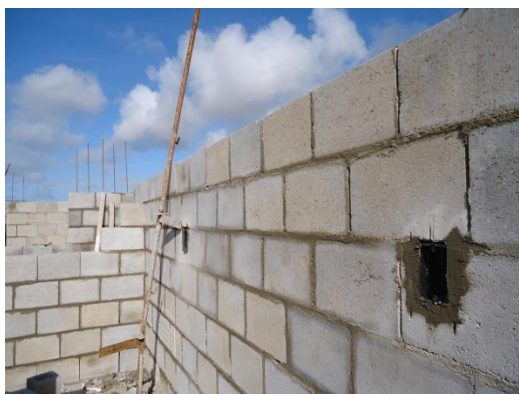
Figura 54: Bloco elétrico cortado no local de utilização.
