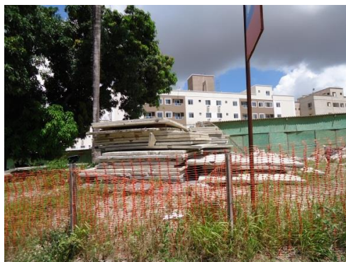
Figura 58– Estoques de lajes maciças utilizadas no empreendimento.
