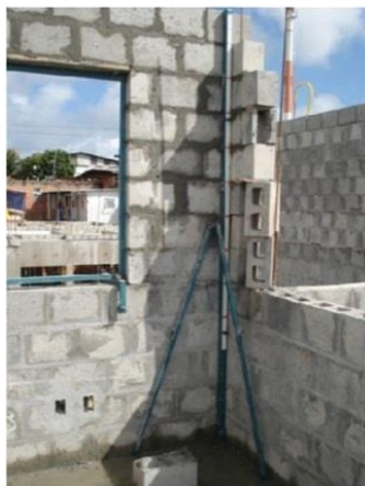
Figura 28: Alvenaria estrutural executada com escantilhão metálico.
