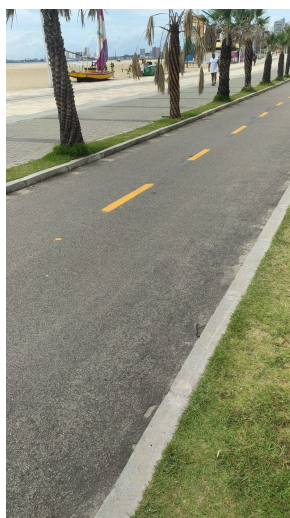
Figura 28 - Trecho 02 Beira Mar, próximo ao Ponto Mar Hotel.
