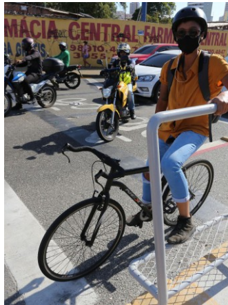
Figura 07 - Parapés instalados em Fortaleza.
