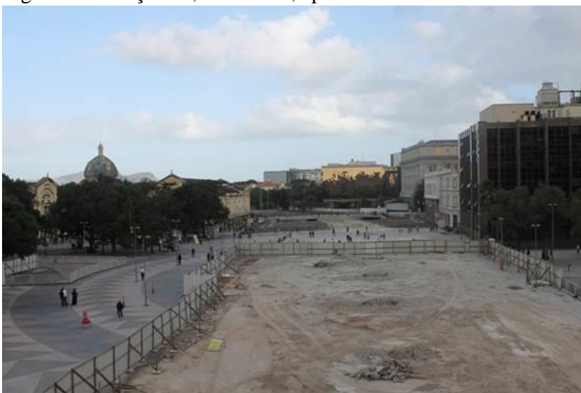
Figura 13 - Praça XV, no Centro, após a retirada do Elevador da Perimetral
