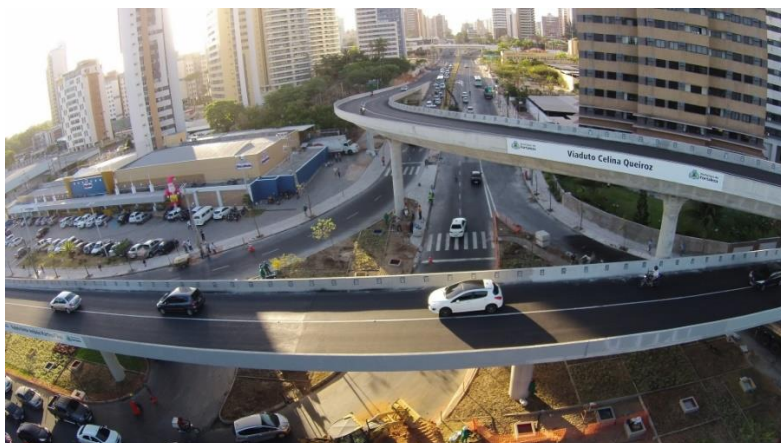
Figura 4 – Vista aérea das faixas de pedestre deslocadas sob o viaduto em 2014.
