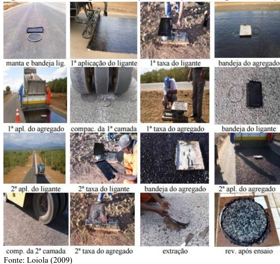
Figura 18 – Metodologia utilizada por Loiola para moldagem em campo
