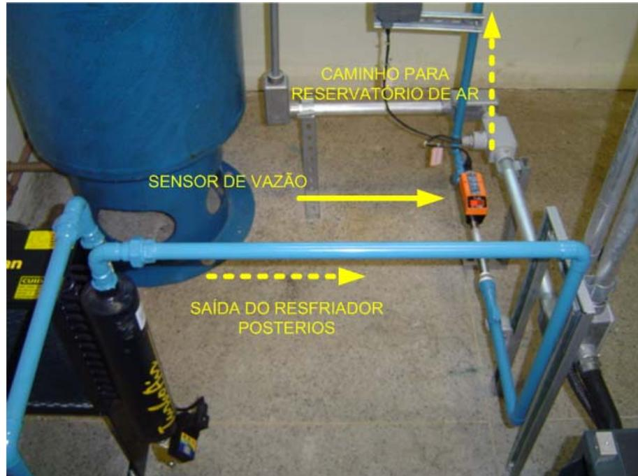
Figura 4.6 – Aspecto Físico do Sensor de Vazão
