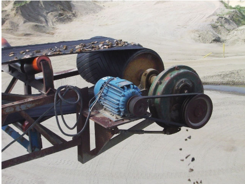
Figura 3.8 - Redutor de velocidade da correia transportadora conectada ao motor de 5 CV via correia em “V”.
