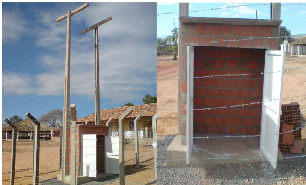
Figura 5.16 – Estrutura para receber o sistema fotovoltaico.
