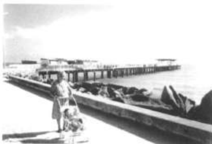
FIGURA 81 - Ponte Metálica, onde funcionou o antigo porto da cidade, em adiantado estado de deterioração. (Fonte: Postais Panorama/Foto chacon)
