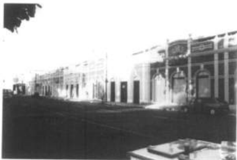
FIGURA 53 - Conjunto de antigos galpões defronte ao Centro Dragão do Mar de Arte e cultura, com a nova roupagem implementada pelo Projeto Cores da Cidade. (Fotografia: Valéria Jacinto/novembro de 2001)
