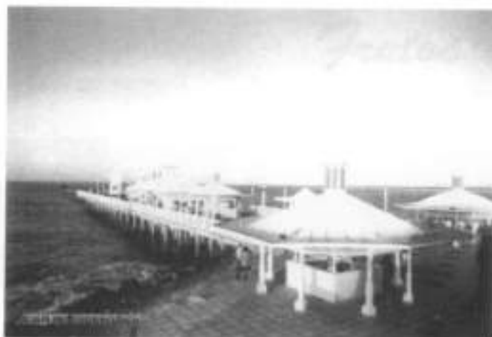
FIGURA 80 - Ponte dos Ingleses, reformada em 1994, segundo projeto dos arquitetos Fausto Nilo e Delberg Ponce de Leon. (Fonte tirada pela autora/junho de 2000)
