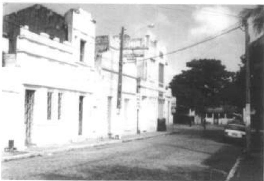
FIGURA 43 - Exemplar remanescente do casario da década de 1930, exibindo estética Art Decô, situado à Rua dos Potiguaras. (Fotografia: Tiago Veras/junho de 2000)
