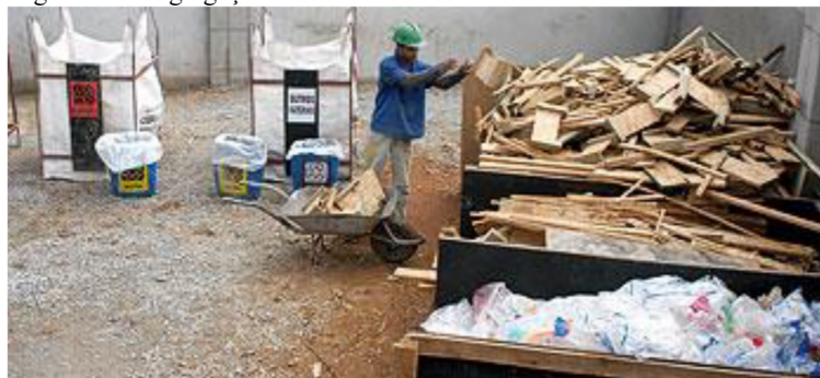
Figura 17 - Segregação de resíduos em canteiro de obras
