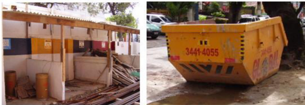
Figura 19 - Utilização de baias fixas e caçambas estacionárias para o acondicionamento dos RCC
