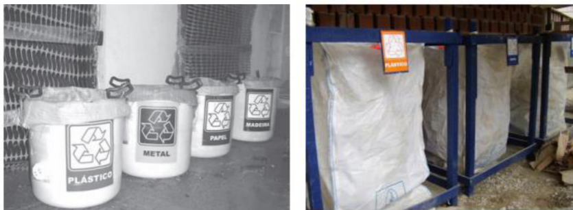
Figura 18 - Utilização de bombonas e bags para o acondicionamento dos RCC
