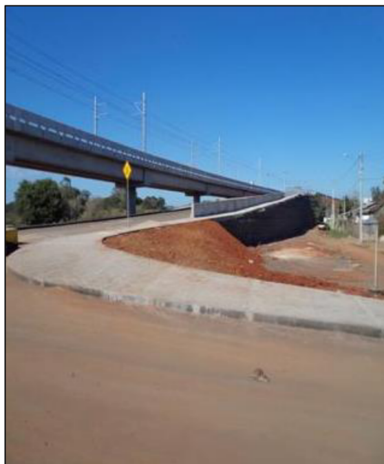
Figura 12 - Resultado final da obra de uso com microgrelhas
