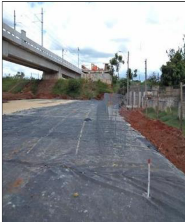
Figura 11 - Aplicação da Microgrelha em obra
