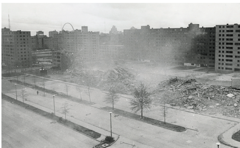
[3] Sequência da demolição do conjunto habitacional Pruitt-Igoe, em 1972, considerado por Charles Jencks como o final simbólico do modernismo. Acervo: RAMROTH, William G. Planning for Disaster: How Natural and Man-made Disasters Shape the Built Environment. Kaplan Publishing: 2007, p. 166.
