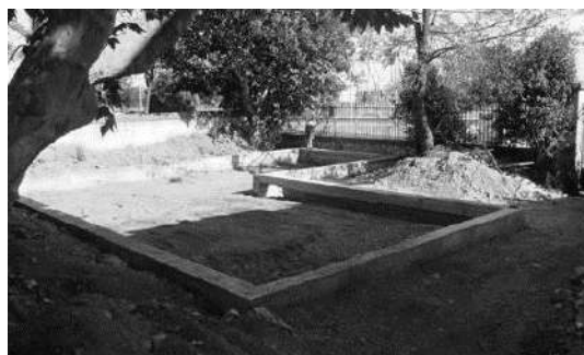
Figura 49 | Sapata Corrida Fonte: Minha casa container (2016) em Júnior (2017)
