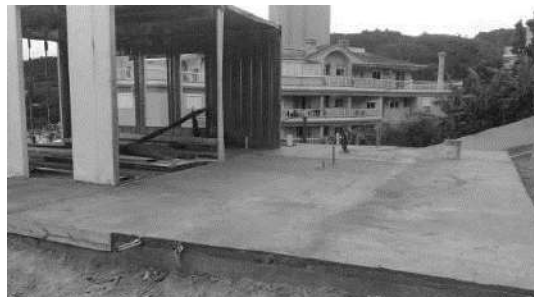
Figura 47 | Fundação do tipo radier Fonte: Minha casa container (2016) em Junior (2017)
