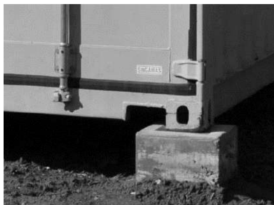
Figura 48 | Blocos de fundação com chapa de fixação Fonte: Brsete (2016) em Junior (2017)
