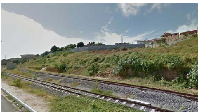
▲ FIGURA 16: ENCOSTA DO MORRO DE SANTA TEREZINHA FONTE: GOOGLE STREET VIEW
