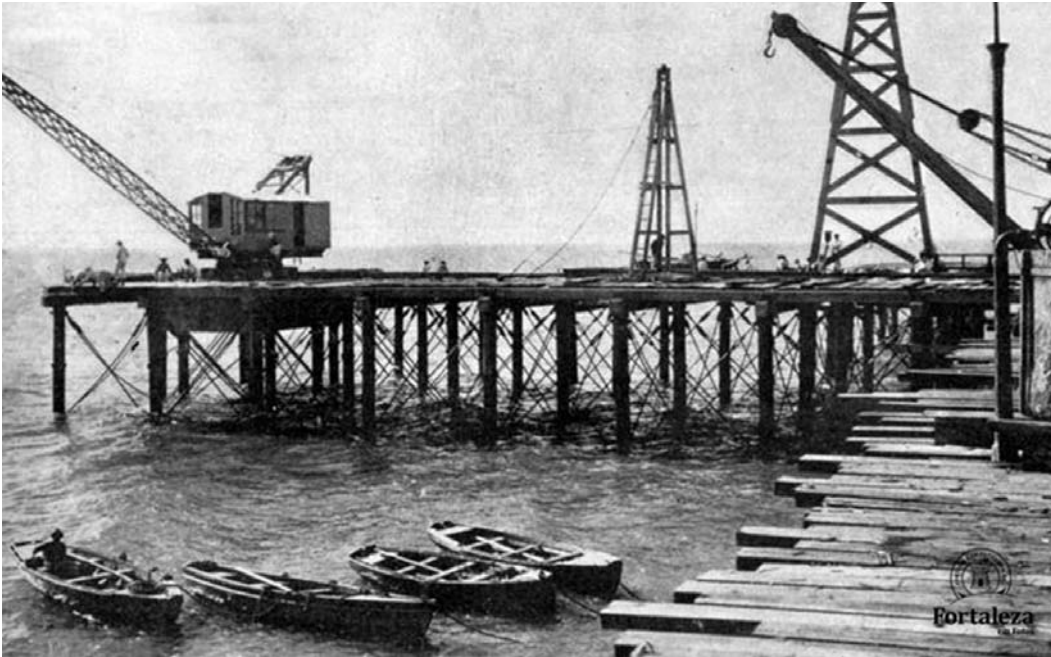
▲ FIGURA 09: CONSTRUÇÃO DA PONTE METÁLICA, 1902 FONTE: http://www.fortalezaemfotos.com.br/2014/11/verdes-mares-bravios-e-um-porto-inseguro.html
