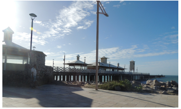
Imagem 58- Ponte Metálica. Fonte: Acervo pessoal
