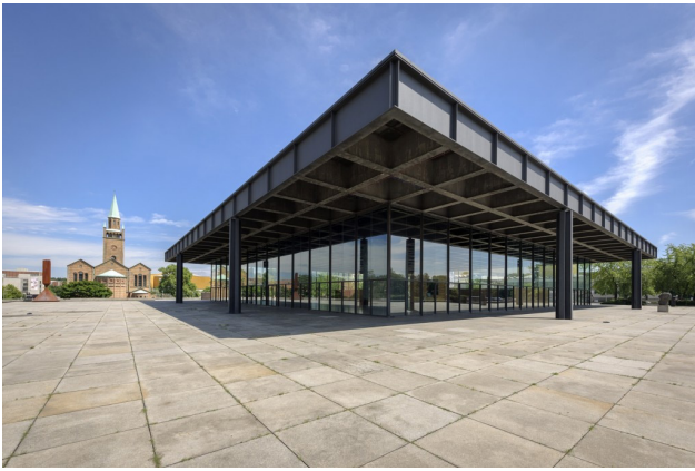
Imagens 06 e 07 - Exemplo de museu modernista. Mies van der Rohe, Neue Nationalgalerie, 1965-1968, Berlin, Alemanha. Neste caso, o suporte tradicional, a parede, desapareceu completamente. Com muita iluminação natural. Um pavimento no subsolo, sem aberturas para o exterior, guarda os serviços do museu. Fonte: https://en.wikipedia.org
