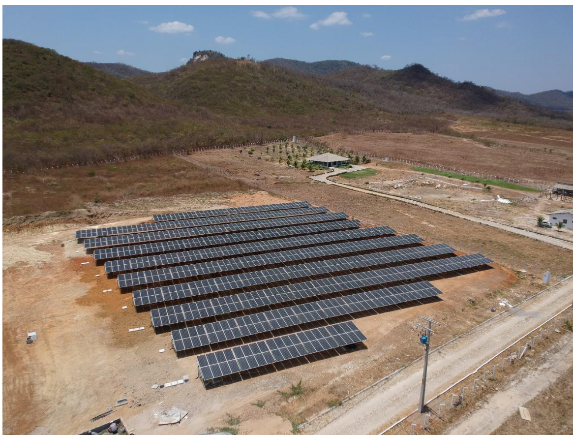
Figura 9 – Imagem aérea da usina
