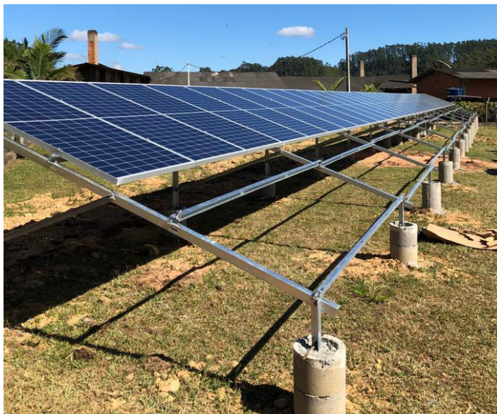
Figura 8 – Instalação de estruturas em solo
