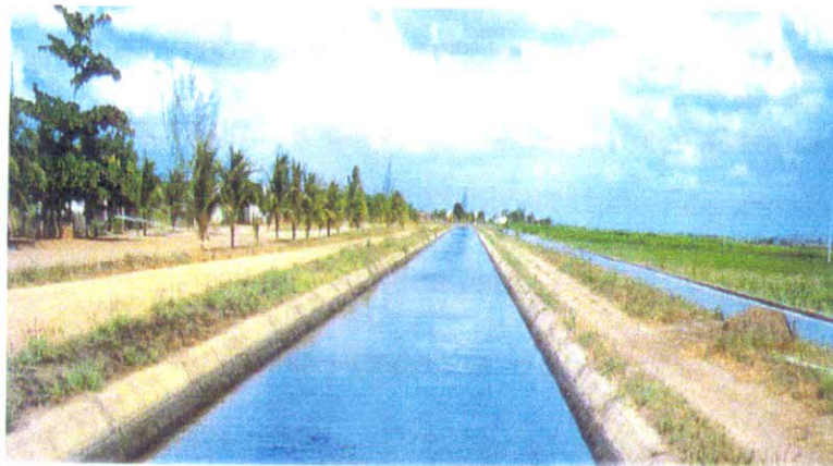
FIGURA 24 – Canal Principal, no Início da Ocupação do Perímetro
