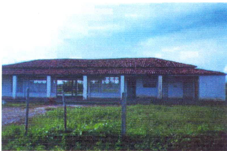
FIGURA 16 – Centro Comunitário do Perímetro de Irrigação de Morada Nova – CE, 2002
