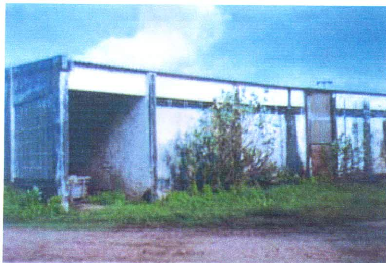
FIGURA 23 – Local Onde Funcionava a Indústria de Parbolização de Arroz do Perímetro de Irrigação de Morada Nova – CE, 2002
