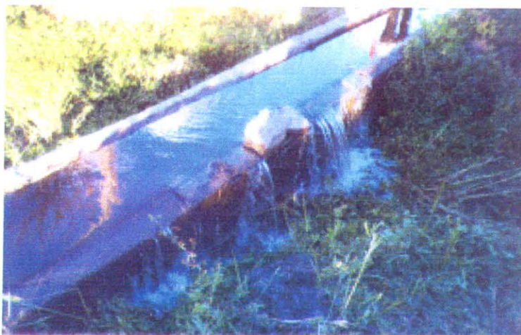
FIGURA 12 – Desperdício de Água no Canal Secundário do Perímetro de Irrigação de Morada Nova – CE, 2002
