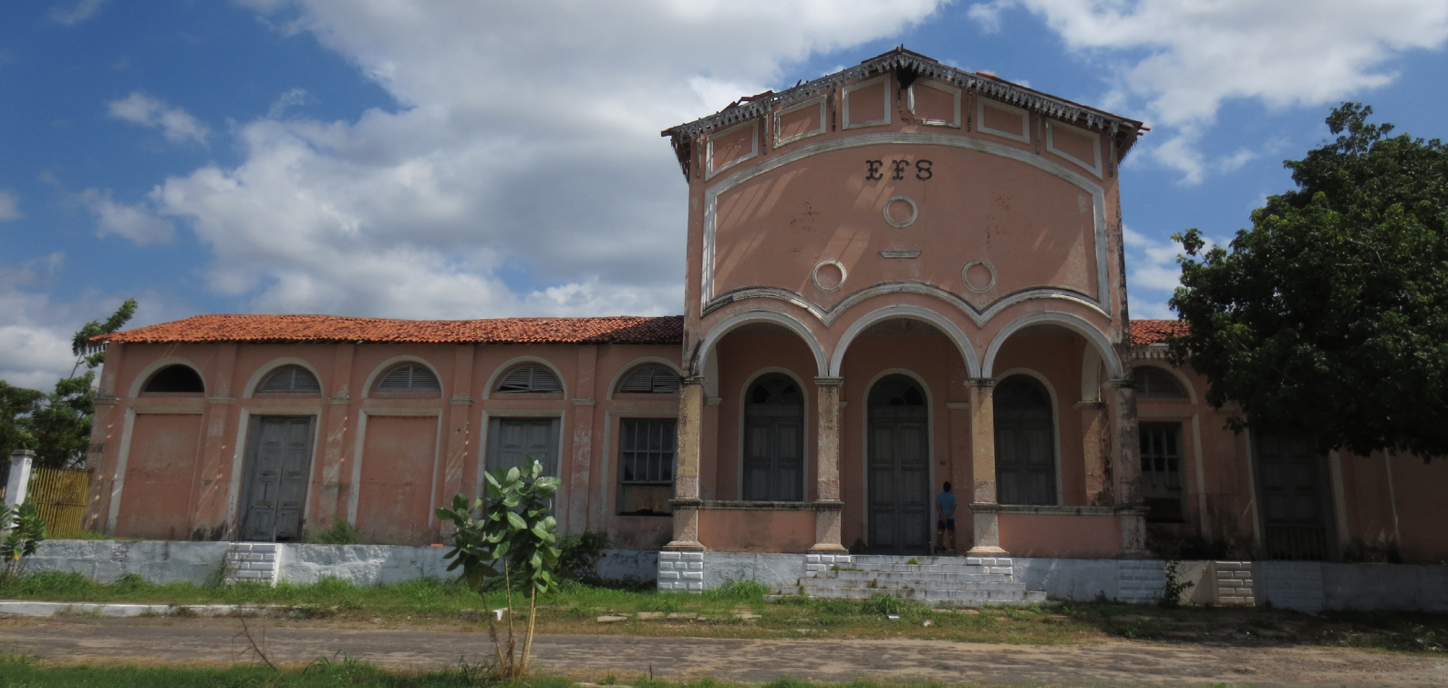
Imagem 4. Estação Ferroviária de Sobral. Fonte: Acervo próprio.
