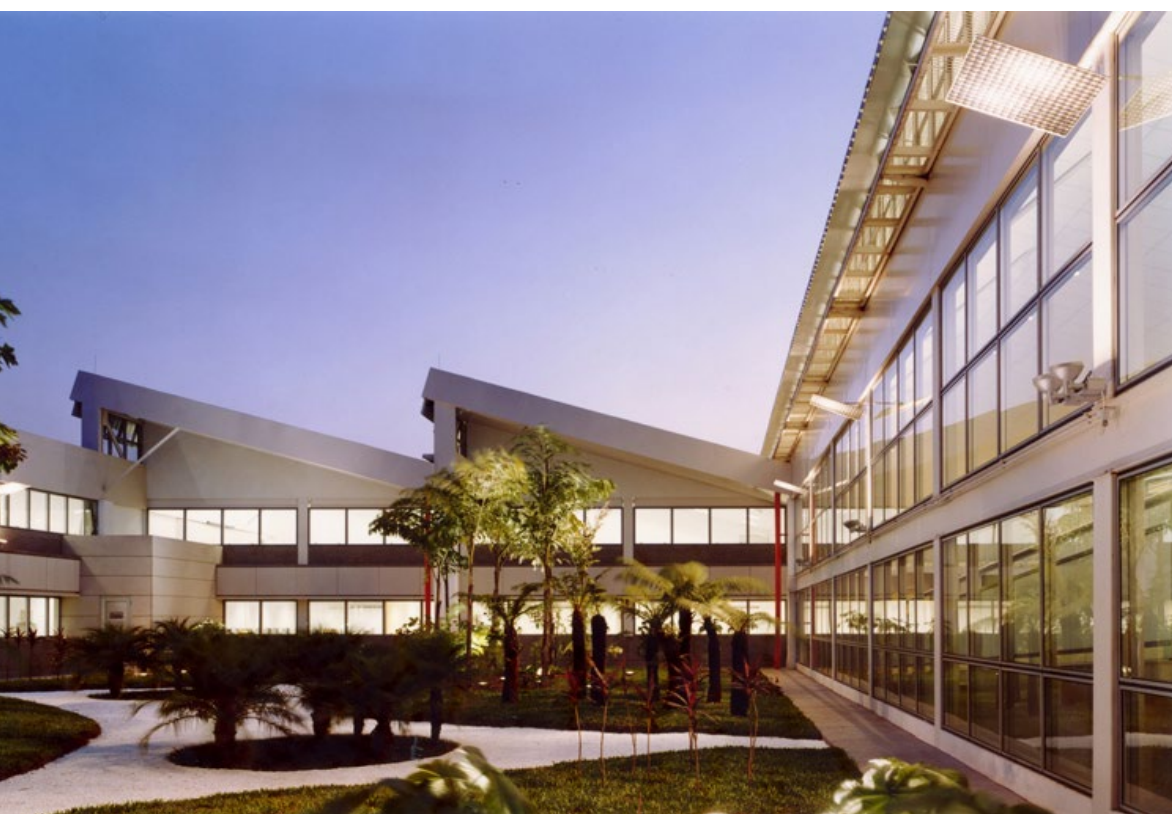
Figura 4.02 - SENAC Santo Amaro - Santo Amaro/SP, vista externa do SHED. fonte: http://www.purarquitetura.arq.br/item.php?id=2&p=49
