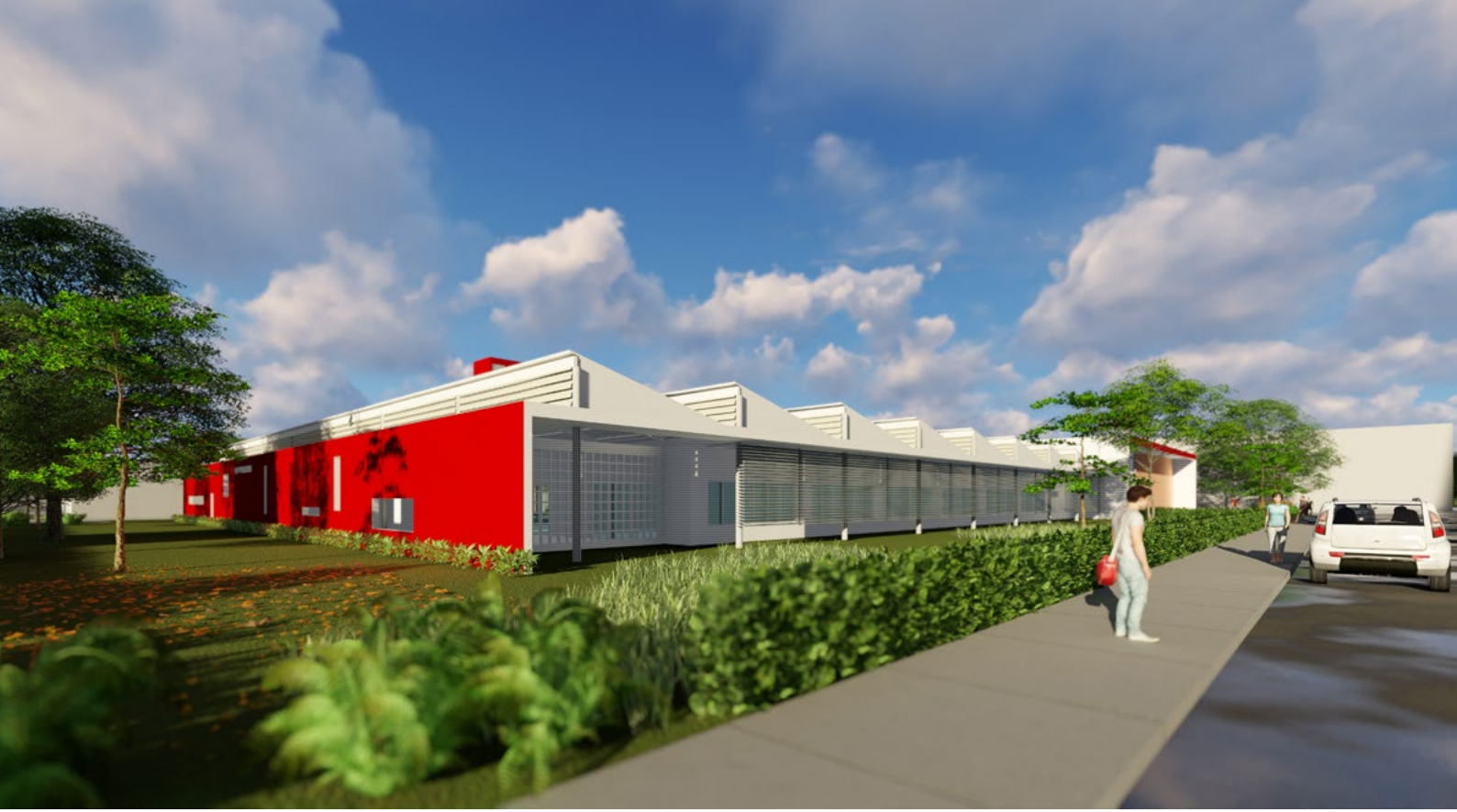
Fig. 6.15 - Vista das Fachadas Sul e Oeste
