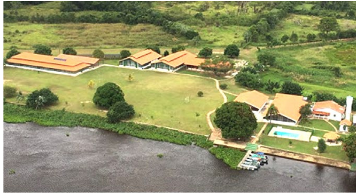
Figura 1 – Vista aérea da Escola Jatobazinho
