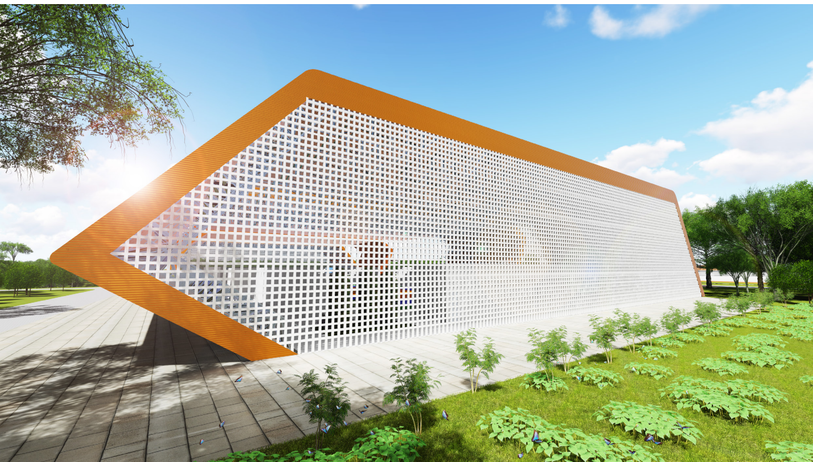
Figura; 6.72: A permeabilidade é aumentada pelos cobogós de concreto presente nas extremidades.
