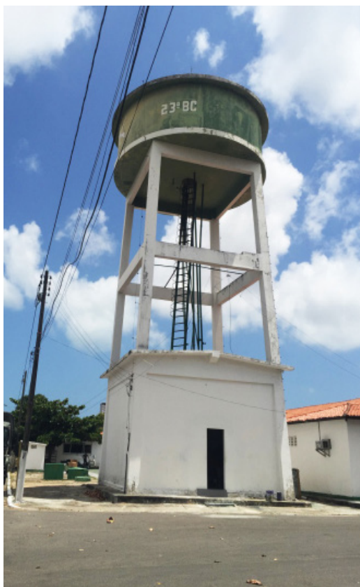
Figura 5.63: Caixa d'água. Fonte: autora
