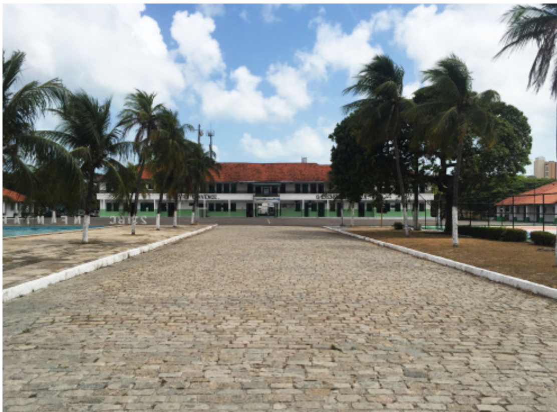
Figura 5.60: Acesso principal em pedra. Fonte: autora
