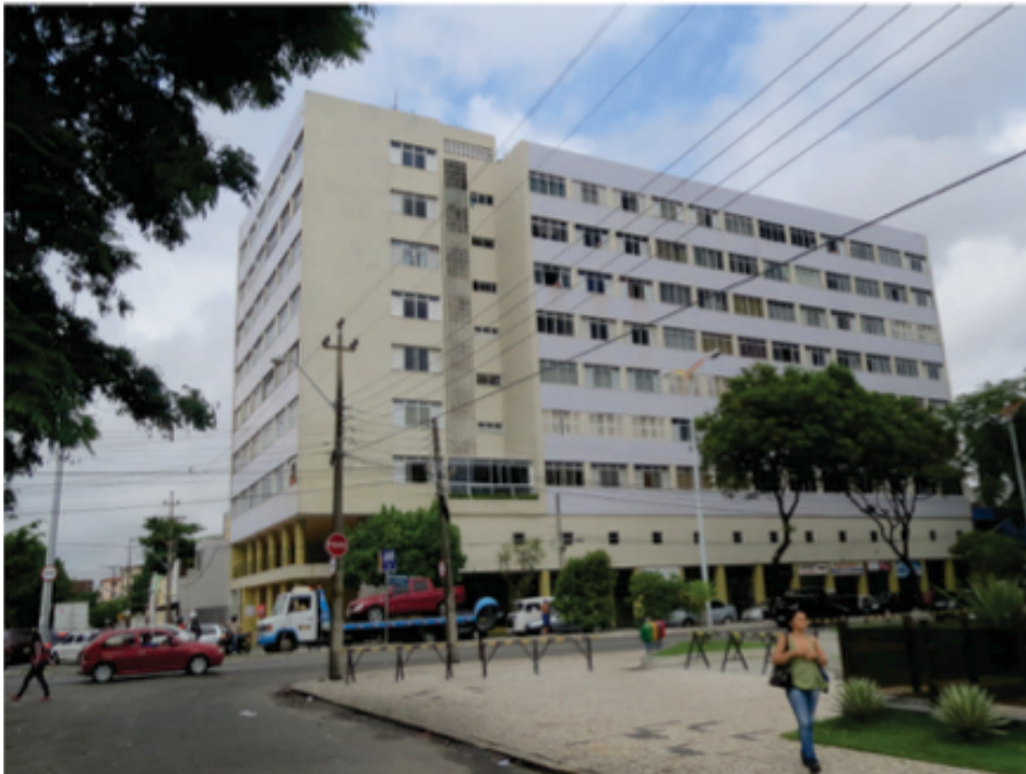
FIGURA 3.5.2 O Edifício Palácio Coronado e sua relação com o entorno.
