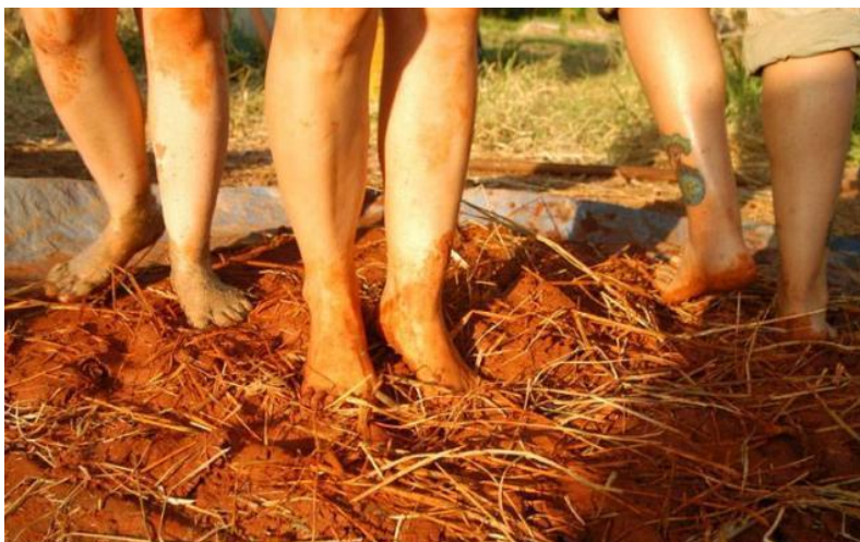
Figura 10 - Mistura da massa de adobe e palha com os pés
