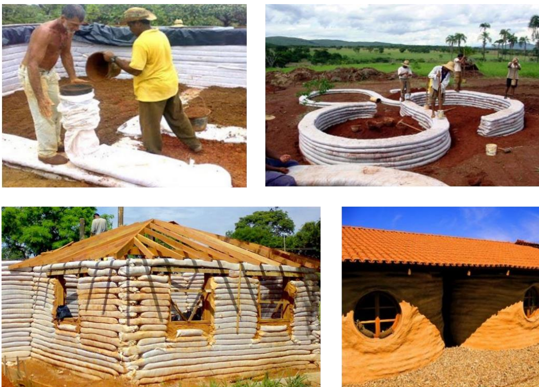
Figura 6 - Processo produtivo do superadobe
