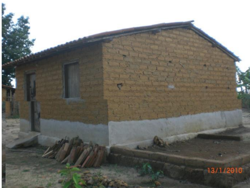
Figura 12 - Casa de adobe em Tianguá-CE
