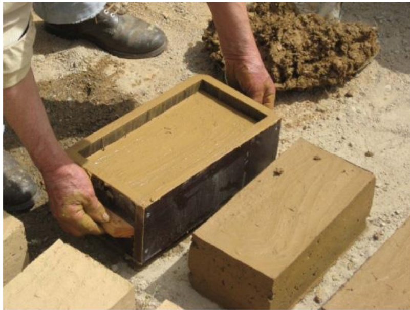
Figura 11 – Fôrma preenchida e bloco já desenformado
