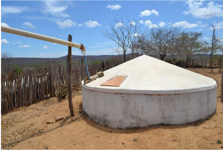
Figura 10: Cisternas para armazenamento de água oriunda das chuvas.
