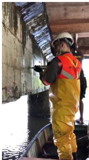
Figura 39 - Realização do ensaio de esclerometria no vão central da ponte
