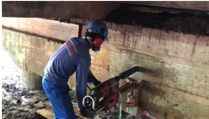
Figura 24 - Extração dos corpos de prova sendo realizada
