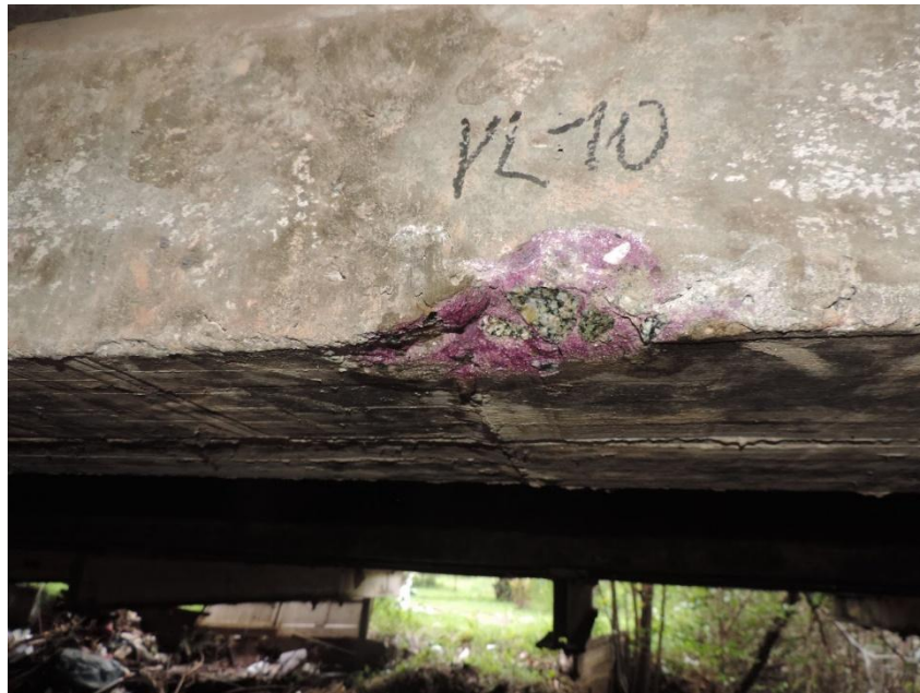
Figura 21 - Ensaio de profundidade de carbonatação V111
