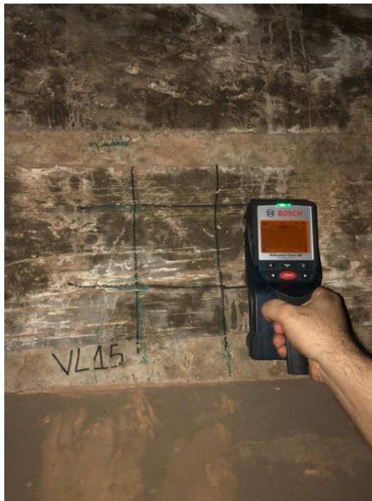
Figura 23 - Realização do ensaio de pacometria em viga
