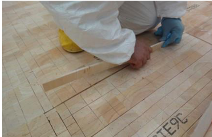
Figura 14 Preenchimento de gaps com filetes de núcleo
