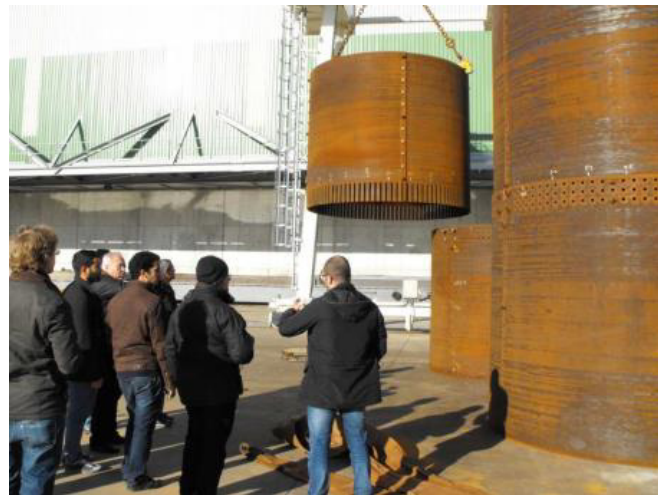
Figura 15: Torre em testes de montagem antes da preparação superficial
