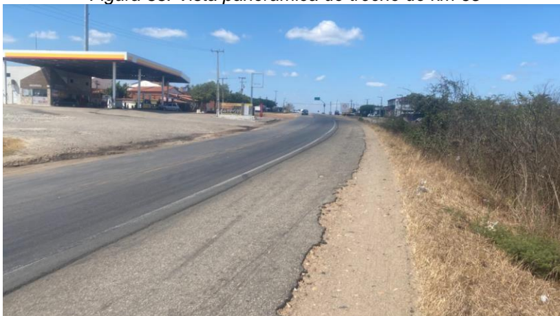
Figura 33: Vista panorâmica do trecho do km 65
