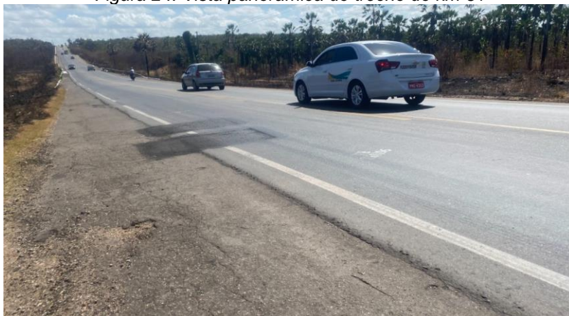
Figura 24: Vista panorâmica do trecho do km 61
