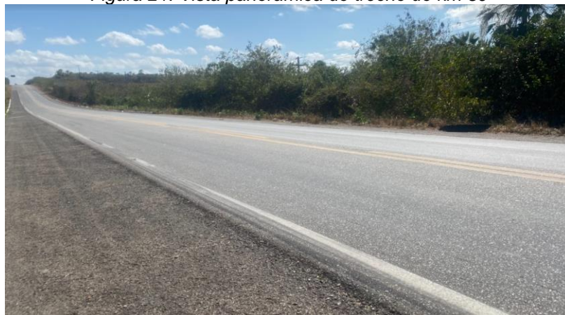
Figura 21: Vista panorâmica do trecho do km 59
