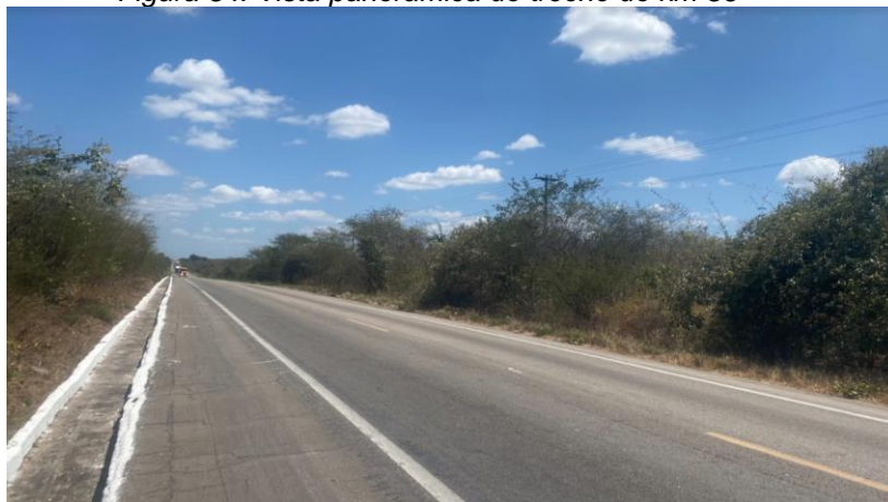
Figura 54: Vista panorâmica do trecho do km 86
